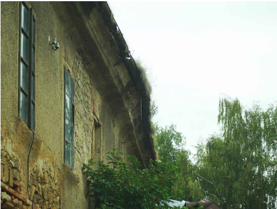
Severní fasáda vyvalená část schodišťové stěny
