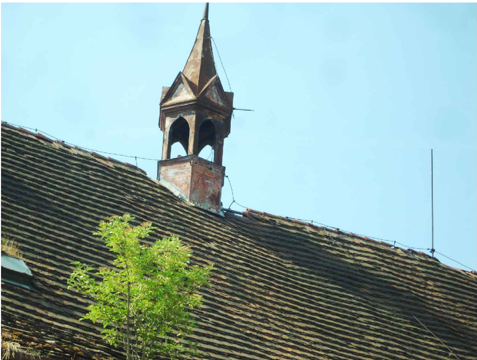
Sanktusníková věžička propad krovu v hřebeni
