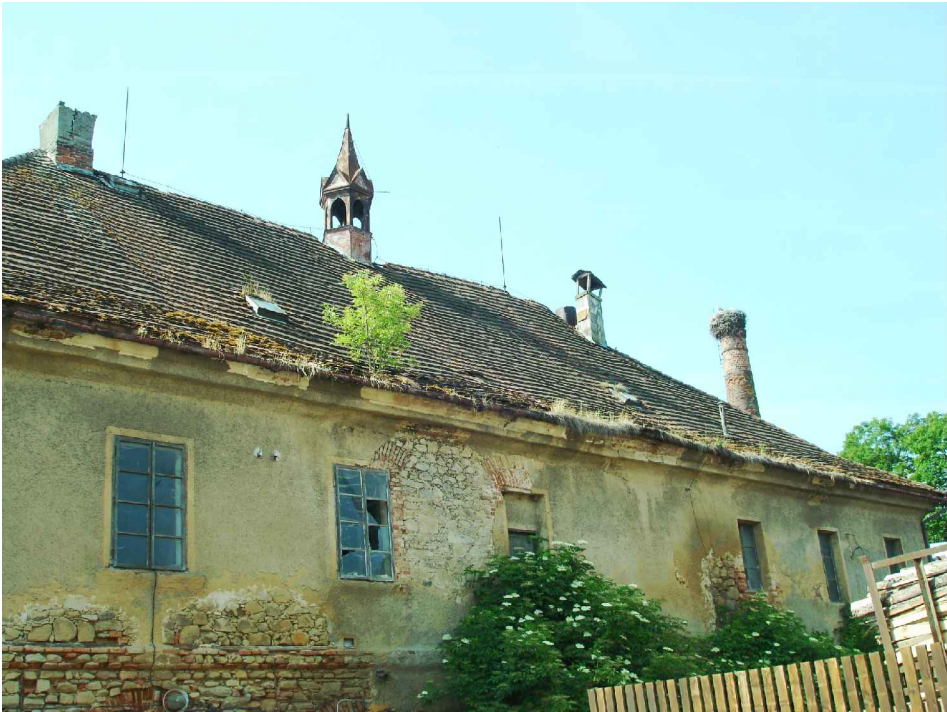
Severní fasáda poškození střechy a krovu, vyvalení schodišťové stěny
